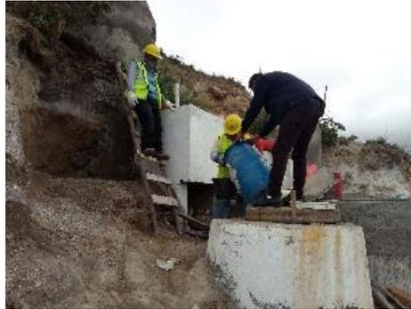
FLOCULANTE ADAPTADO EN EL DESARENADOR DE LAS PTAR TECHO PROPIO 3 (elevación de pared del floculante)
