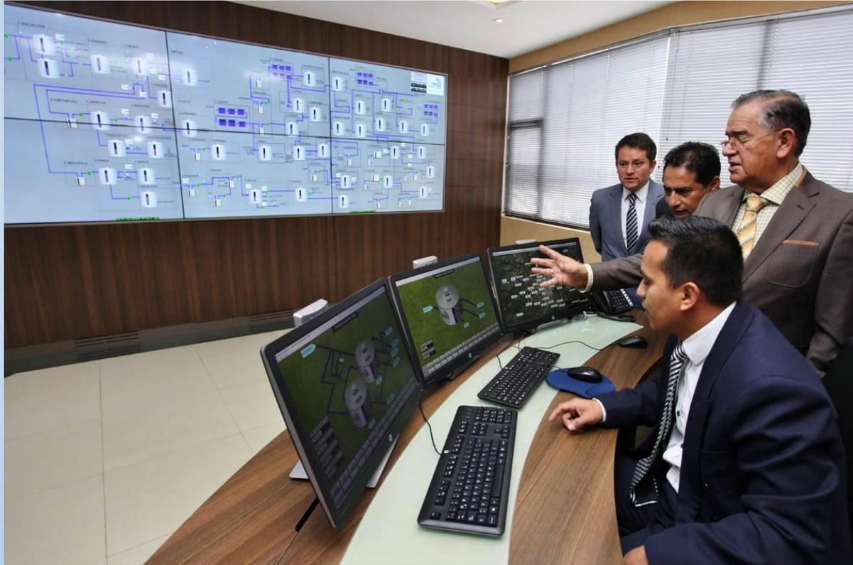
Se implementó y se acondiciono el sistema de control y monitoreo de las redes de agua potable y alcantarillado con equipos sofisticados de última generación, desde el edificio matriz se monitorea las diferentes plantas de tratamiento, estaciones de bombeo y tanques de almacenamiento.
